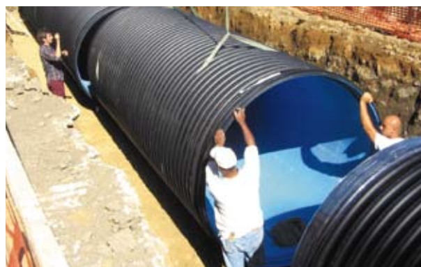
Монтаж трубопроводу DN/ID 2000 мм
