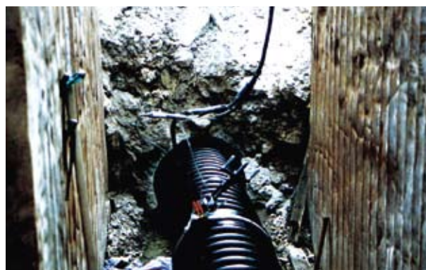
Релайнінг всередині бетонного трубопроводу
