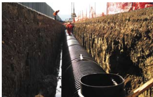
Процес прокладання труб
