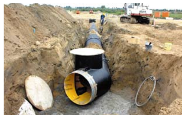
Водовід з відводом і колодязем
