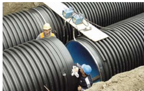
Зварювання труб великого діаметра у вузькій траншеї
