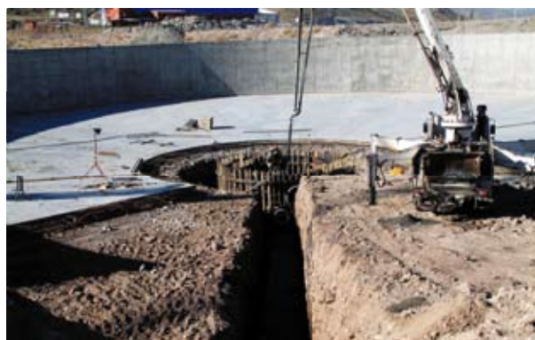
Монтаж ємностей зберігання води для басейну
