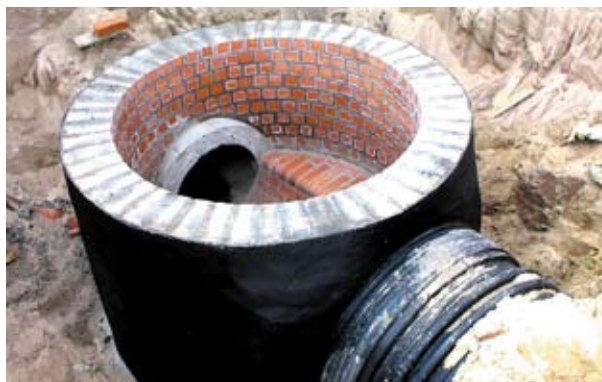
Труба Krahn з колодязем виготовленим з цегли
