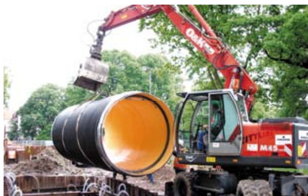
Установлення резервуару для дощової води
