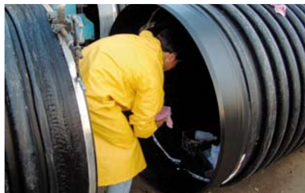
З'єднання труб з допомогою електроплавлення
