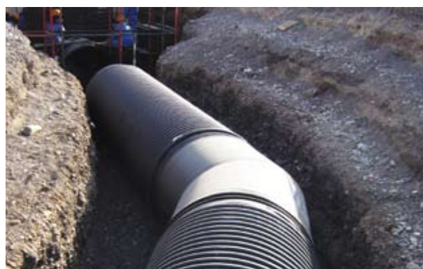
Монтаж трубопроводу DN/ID 2000 мм з фітингами
