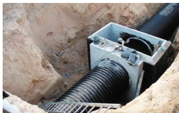
Монтаж трубопроводу з шахтами
