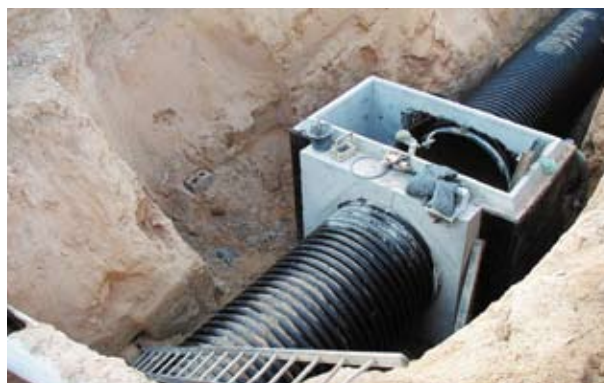
Колектор очисних споруд
