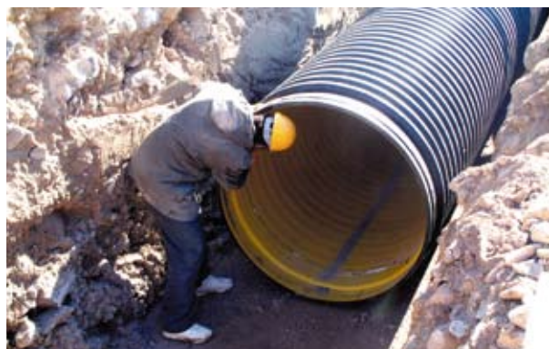
Монтаж труб Krahn у вузькій траншеї
