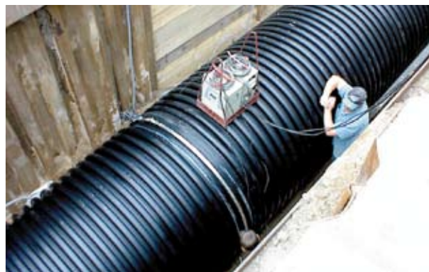
Виконання електрофузійного зварювання в траншеї
